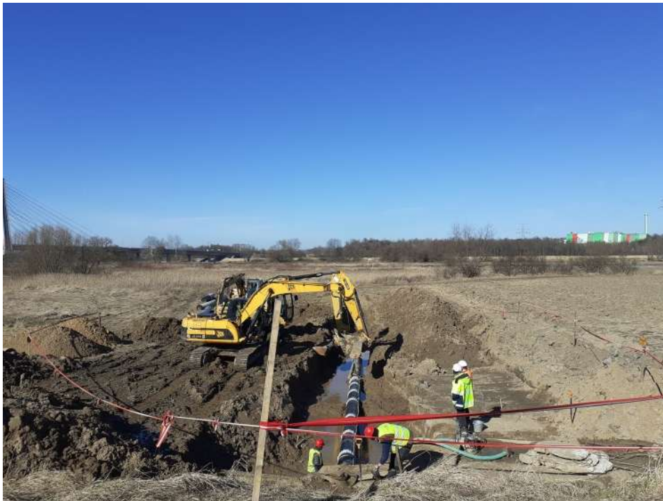
Foto. 97. Prace związane z przebudową sieci gazociągowej – prawy wał Wisły na odcinku 3.3 , stan w trzeciej dekadzie lutego 2022 r. (widok w kierunku międzywala).
