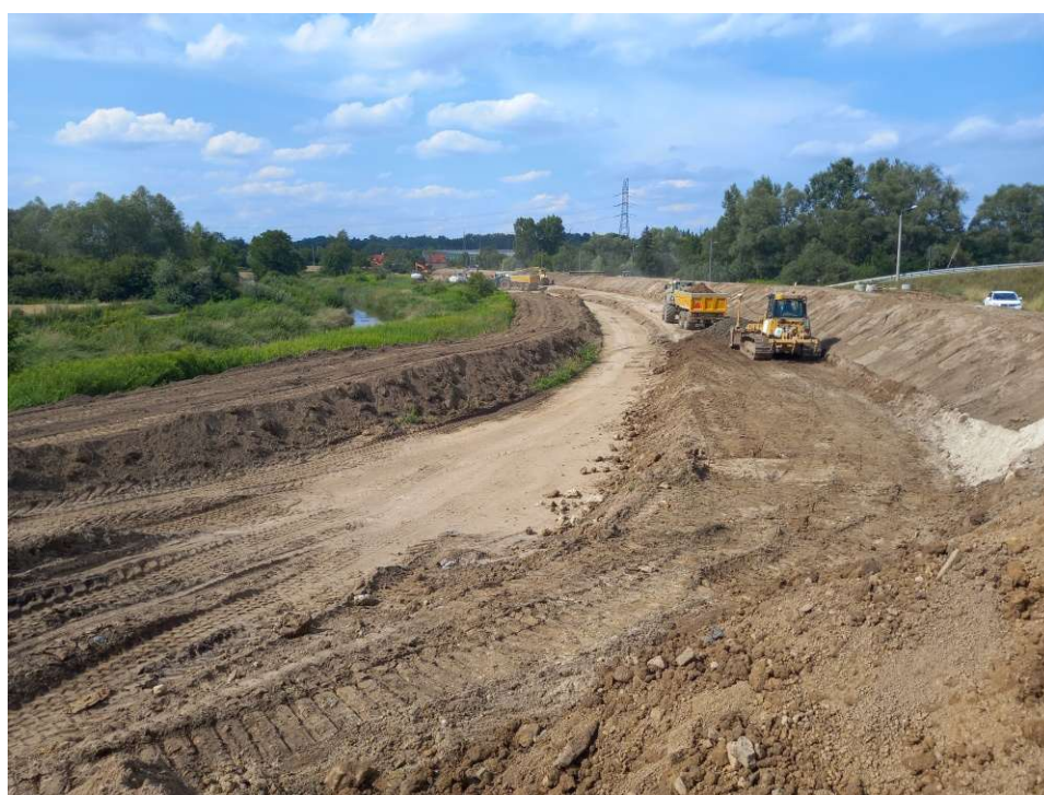
Foto. 38. Formowanie skarp wału przeciwpowodziowego – lewy wał Dłubni na odcinku 1.5 , stan w trzeciej dekadzie lipca 2022 r. (widok w górę rzeki).
