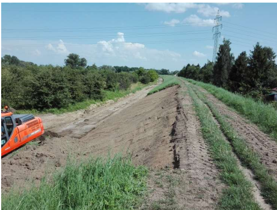
Foto. 86. Zdejmowanie warstwy humusu – prawy wał Wisły na odcinku 3.2a , stan w trzeciej dekadzie lipca 2021 r. (widok w dół rzeki).
