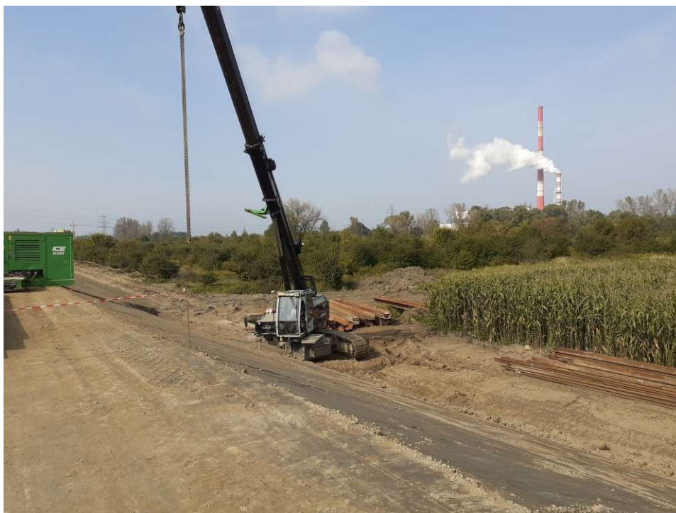
Foto. 91. Wykonywanie ścianki szczelnej zabezpieczającej przebudowywany przepust wałowy – prawy wał Wisły na odcinku 3.2a , stan w trzeciej dekadzie września 2021 r. (widok w górę rzeki).
