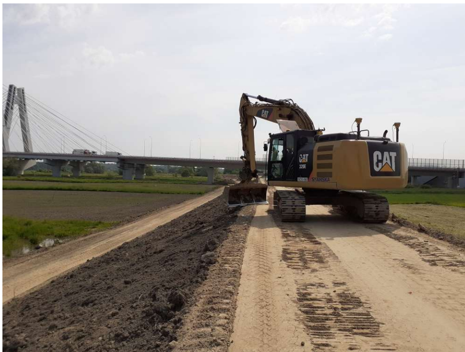
Foto. 108. Humusowanie skarp wału przeciwpowodziowego – prawy wał Wisły na odcinku 3.3 , stan w trzeciej dekadzie maja 2023 r. (widok w dół rzeki).
