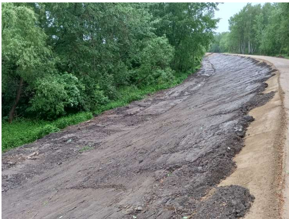
Foto. 43. Humusowanie skarp wału przeciwpowodziowego – lewy wał Wisły na odcinku 1.3 , stan w trzeciej dekadzie maja 2022 r. (widok w górę rzeki).
