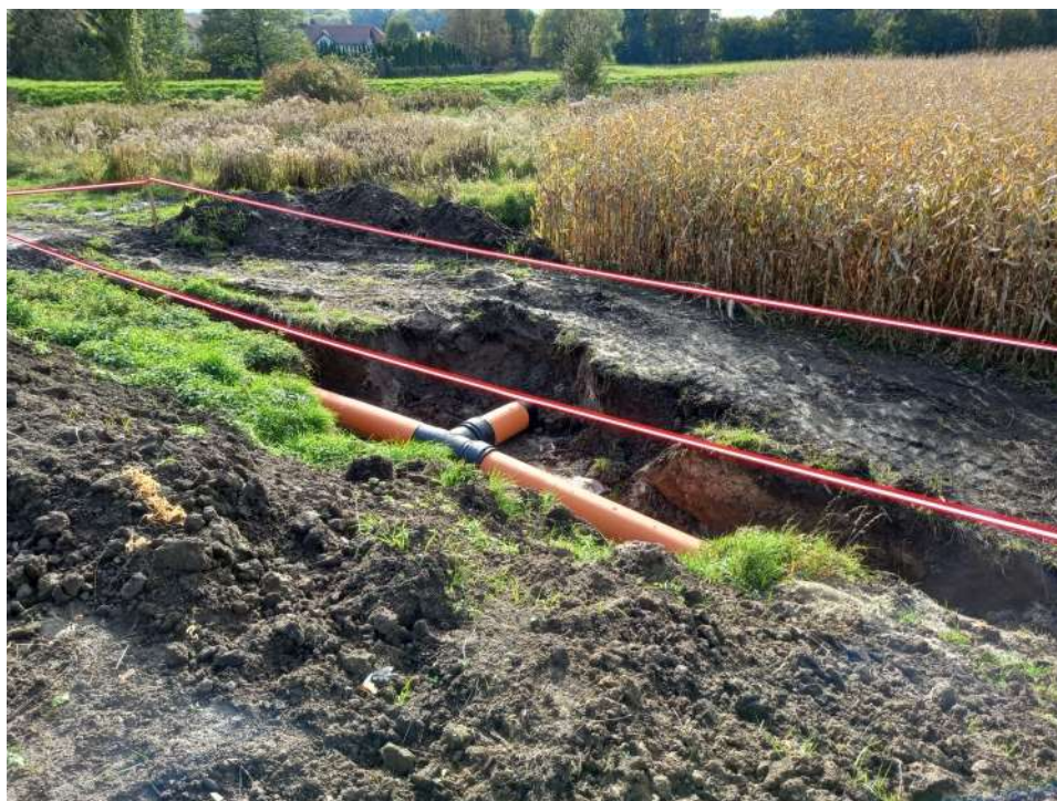
Foto. 35. Prace związane z przebudową sieci gazociągowej – prawy wał Dłubni na odcinku 1.4 , stan w drugiej dekadzie października 2021 r. (widok w dół rzeki).
