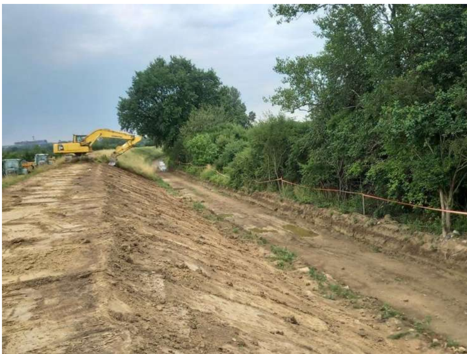
Foto. 85. Zdejmowanie warstwy humusu – prawy wał Wisły na odcinku 3.4 , stan w pierwszej dekadzie lipca 2022 r. (widok w górę rzeki).
