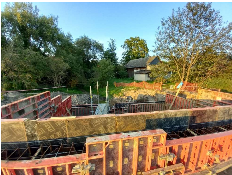
Foto. 34. Budowa przepustu wałowego – lewy wał Dłubni na odcinku 1.6 , stan w trzeciej dekadzie sierpnia 2022 r. (widok w stronę zawala).
