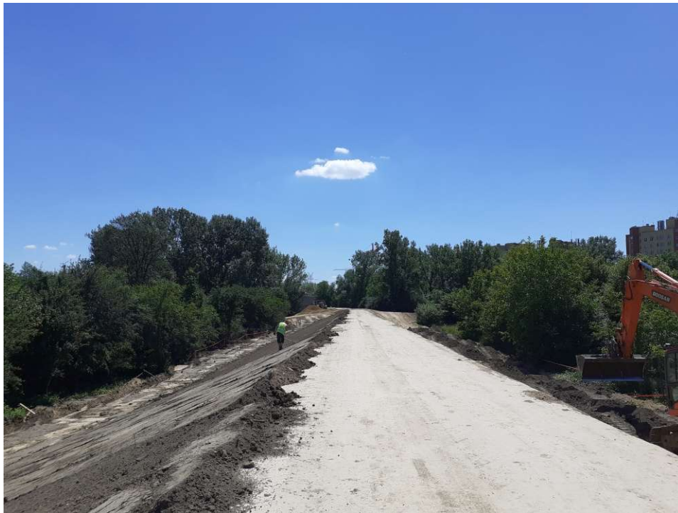
Foto. 107. Humusowanie skarp wału przeciwpowodziowego – prawy wał Wisły na odcinku 3.2a , stan w trzeciej dekadzie czerwca 2022 r. (widok w dół rzeki).
