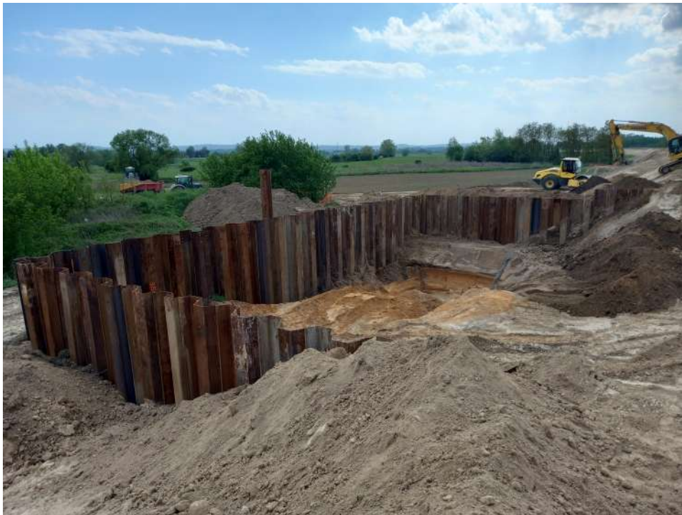
Foto. 33. Przebudowa przepustu wałowego – lewy wał Wisły na odcinku 2 , stan w drugiej dekadzie maja 2022 r. (widok w stronę międzywała).
