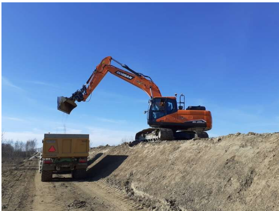
Foto. 103. Wyrównywanie skarp wału przeciwpowodziowego – prawy wał Wisły na odcinku 3.3 , stan w trzeciej dekadzie lutego 2022 r. (widok w górę rzeki).
