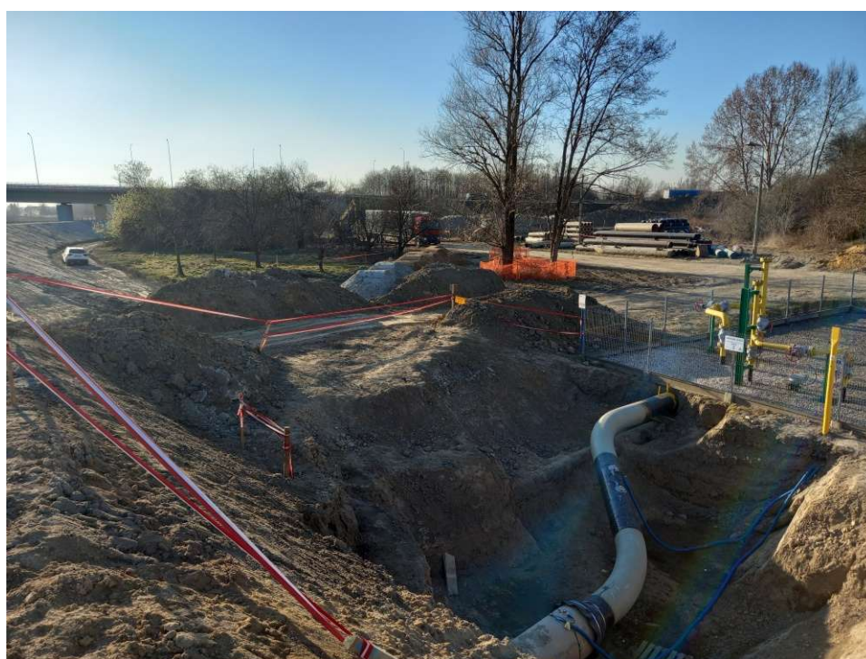
Foto. 36. Prace związane z przebudową sieci gazociągowej – lewy wał Wisły na odcinku 1.2 , stan w trzeciej dekadzie marca 2022 r. (widok w górę rzeki).
