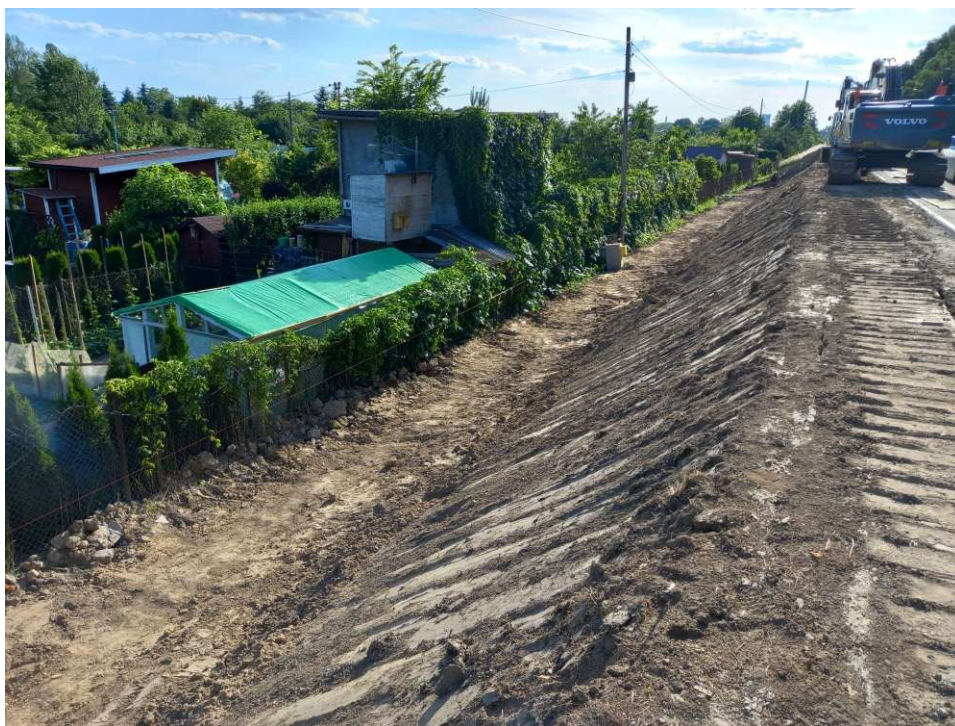
Foto. 39. Wyrównywanie skarp wału przeciwpowodziowego – lewy wał Wisły na odcinku 1.1 , stan w drugiej dekadzie czerwca 2022 r. (widok w górę rzeki).
