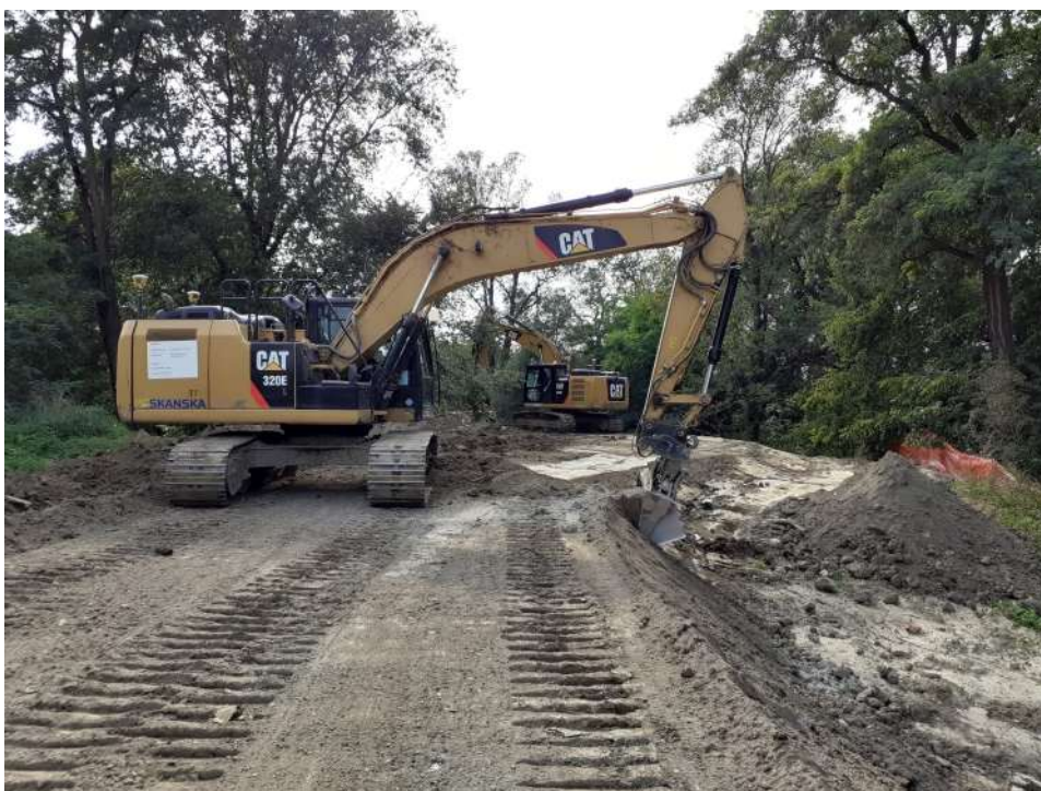
Foto. 102. Formowanie skarp wału przeciwpowodziowego – prawy wał Wisły na odcinku 3.2a , stan w pierwszej dekadzie września 2022 r. (widok w dół rzeki).
