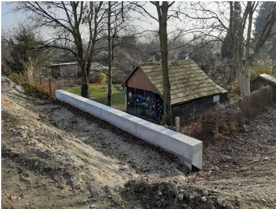
Foto. 95. Budowa muru oporowego – prawy wał Wisły na odcinku 3.2a , stan w drugiej dekadzie listopada 2021 r. (widok w dół rzeki).
