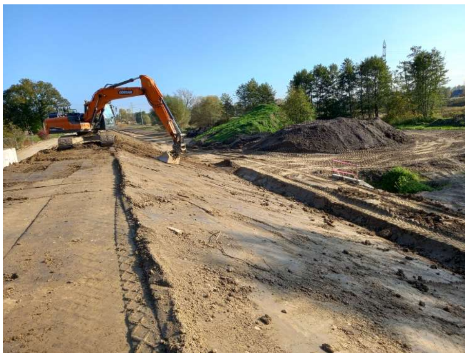
Foto. 40. Wyrównywanie skarp wału przeciwpowodziowego – lewy wał Dłubni na odcinku 1.6 , stan w drugiej dekadzie października 2022 r. (widok w dół rzeki).
