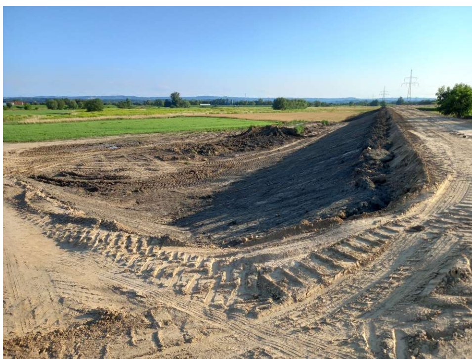
Foto. 44. Humusowanie skarp wału przeciwpowodziowego – lewy wał Wisły na odcinku 2 , stan w trzeciej dekadzie lipca 2022 r. (widok w górę rzeki).
