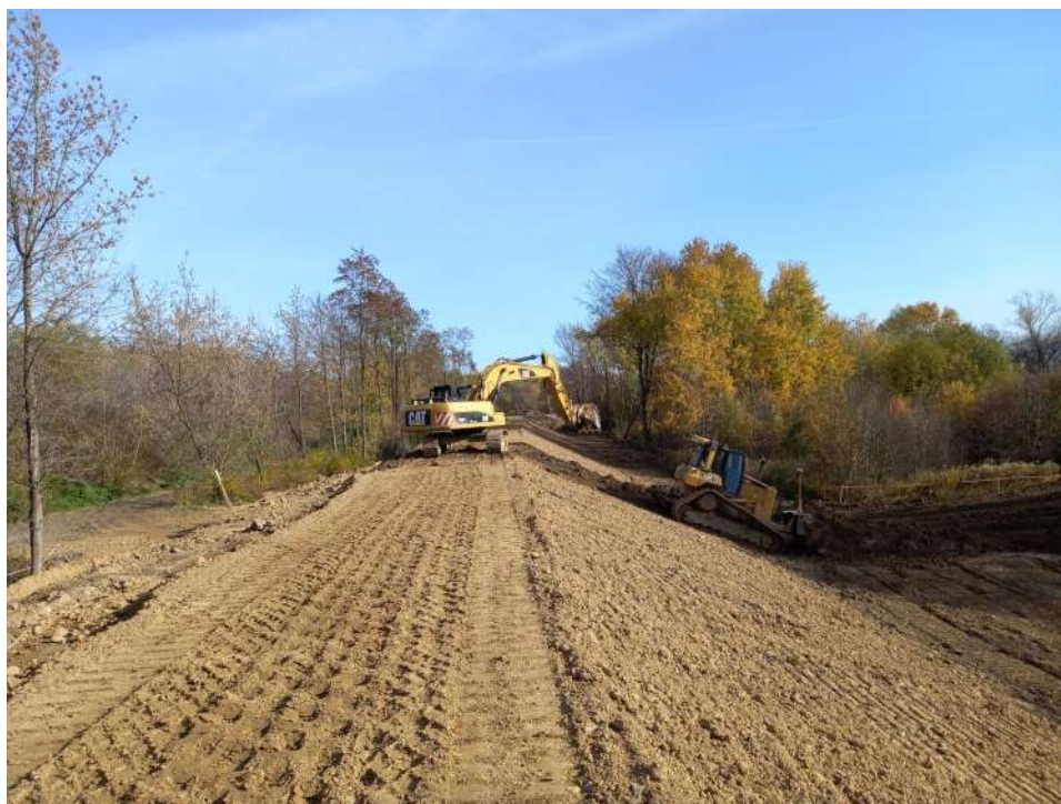
Foto. 37. Formowanie skarp wału przeciwpowodziowego – lewy wał Wisły na odcinku 1.2 , stan w trzeciej dekadzie października 2021 r. (widok w dół rzeki).
