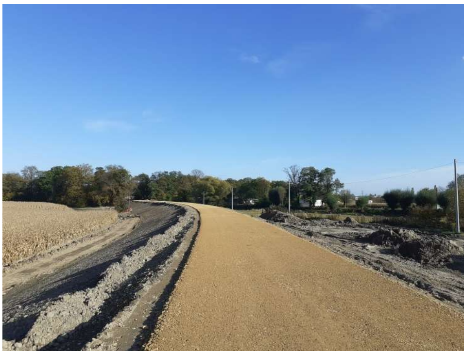
Foto. 109. Budowa drogi na koronie wału przeciwpowodziowego – prawy wał Wisły na odcinku 3.2a , stan w drugiej dekadzie października 2022 r. (widok w dół rzeki).
