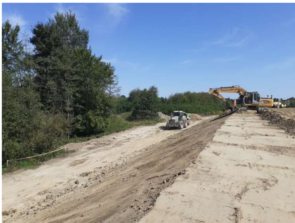
Foto. 104. Wyrównywanie skarp wału przeciwpowodziowego – prawy wał Wisły na odcinku 3.4 , stan w pierwszej dekadzie września 2022 r. (widok w dół rzeki).
