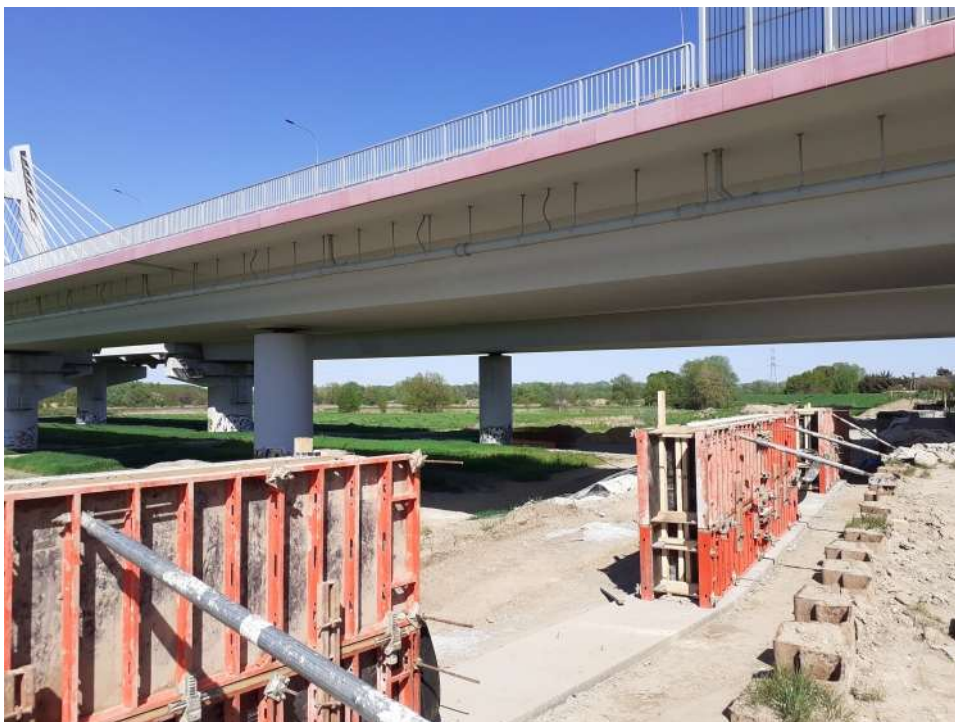
Foto. 96. Budowa muru oporowego – prawy wał Wisły na odcinku 3.3 , stan w pierwszej dekadzie maja 2022 r. (widok w dół rzeki).
