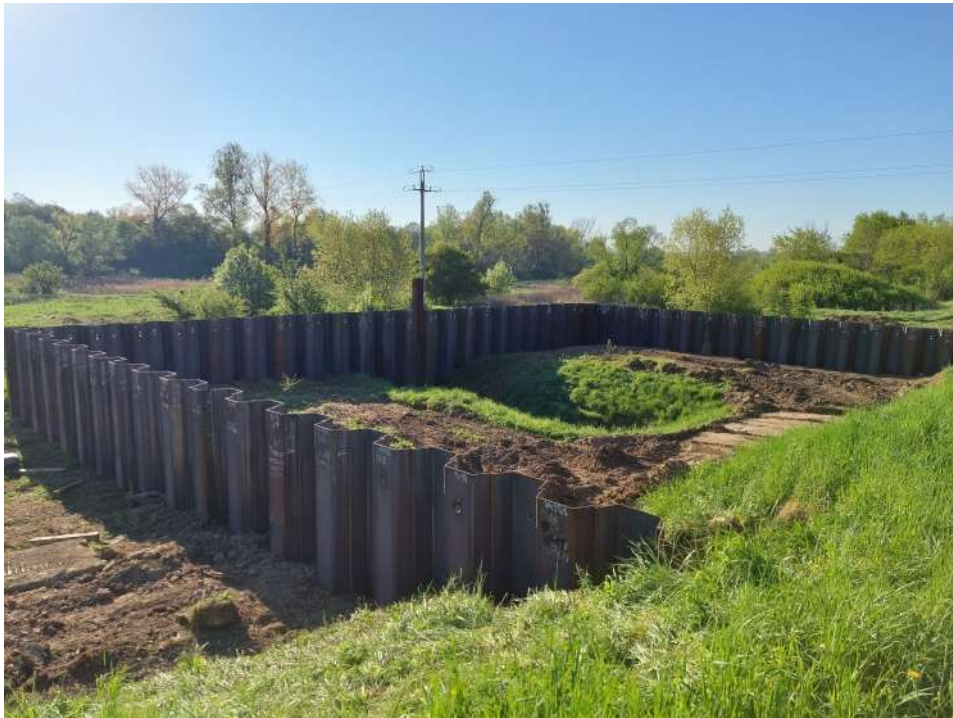
Foto. 92. Ścianka szczelna zabezpieczająca przebudowywany przepust wałowy – prawy wał Wisły na odcinku 3.4 , stan w drugiej dekadzie maja 2021 r. (widok w dół rzeki).
