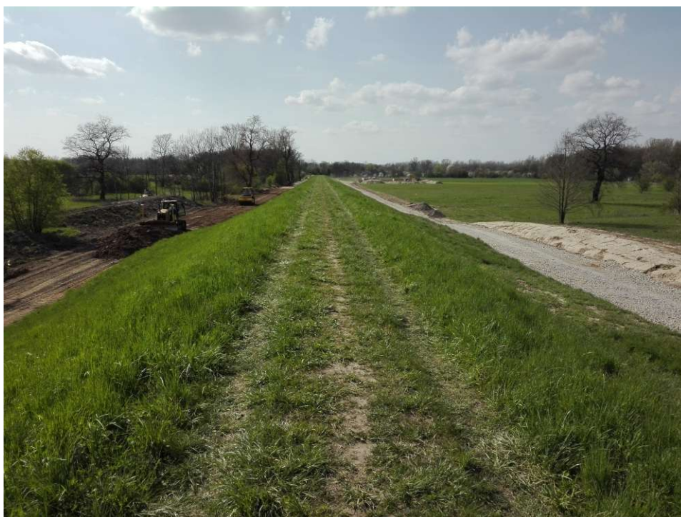
Foto. 26. Zdejmowanie warstwy humusu – lewy wał Wisły na odcinku 2 , stan w trzeciej dekadzie lipca 2021 r. (widok w górę rzeki).
